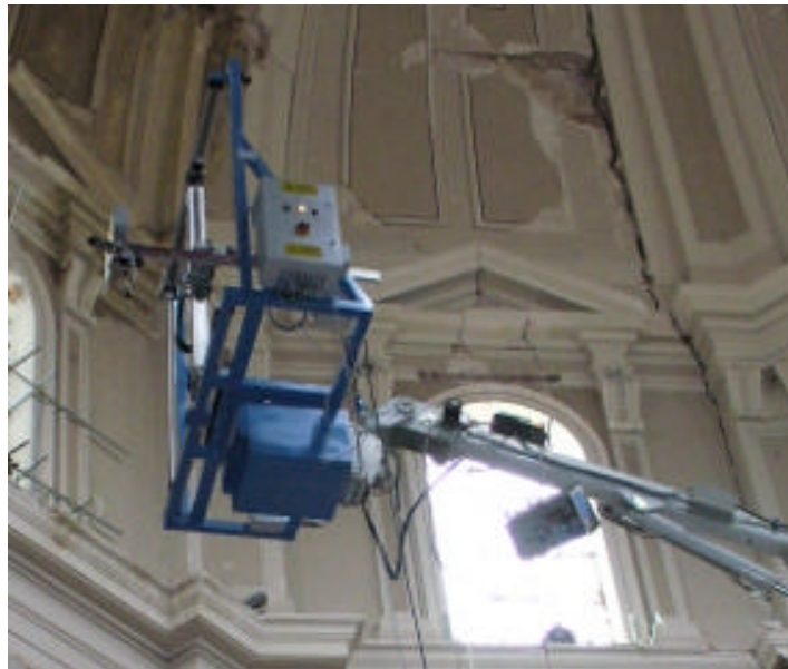
Robot installato sul braccio di una gru.
