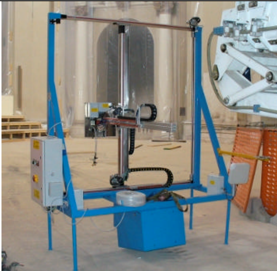
Robot spruzzatura utilizzato nel consolidamento della basilica di San Bernardino danneggiata dal terremoto dell'Aquila del 2009.
